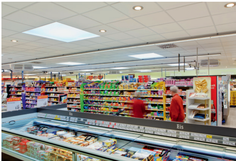
Wohlfühlambiente: Ist im Markt die Decke abgehängt, werden die um UV-Komponenten reduzierten Sonnenstrahlen über Lichtschächte in den Verkaufsraum geleitet.
