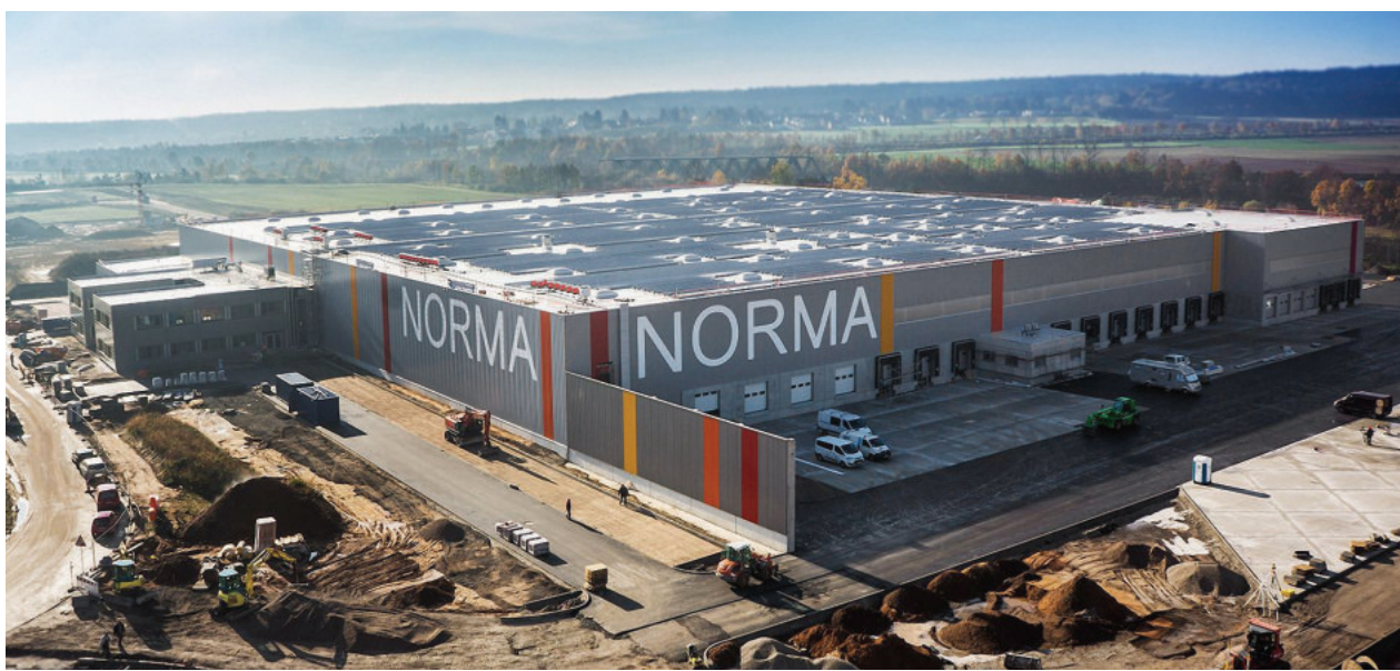
Handelsreferenz: Auf dem Dach seines Fürther Logistikzentrums erzeugt der Goldbeck-Kunde Norma mit 2070 Modulen (Panelfläche insgesamt: 15 000 qm) jährlich über 450 000 Kwh Solarstrom – komplett für den Eigenverbrauch.
